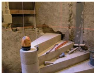
Remplacement de marches sur un escalier en vis [Phot. Archipat]
